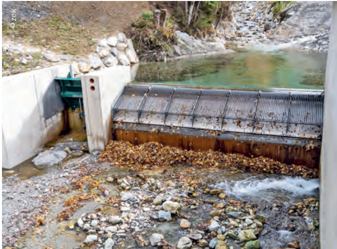
Beim Kraftwerk Klaus erfolgt der Triebwassereinzug durch ein patentiertes Coanda-System von der Südtiroler Wild Metal GmbH.
