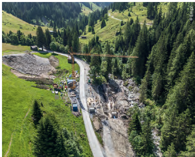
Vogelperspektive auf die Baustelle der Wasserfassung des Kraftwerks Andexer. Die gesamten Hoch- und Tiefbauarbeiten wurden von den Profis der Salzburger Firma Empl Bau aus Mittersill durchgeführt.
