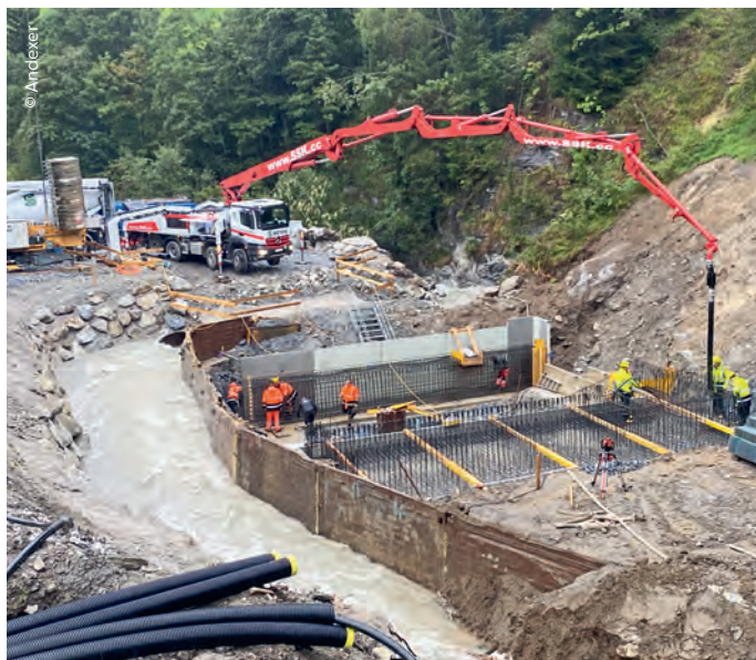
Betonarbeiten an der Wasserfassung des Kraftwerks Klaus
