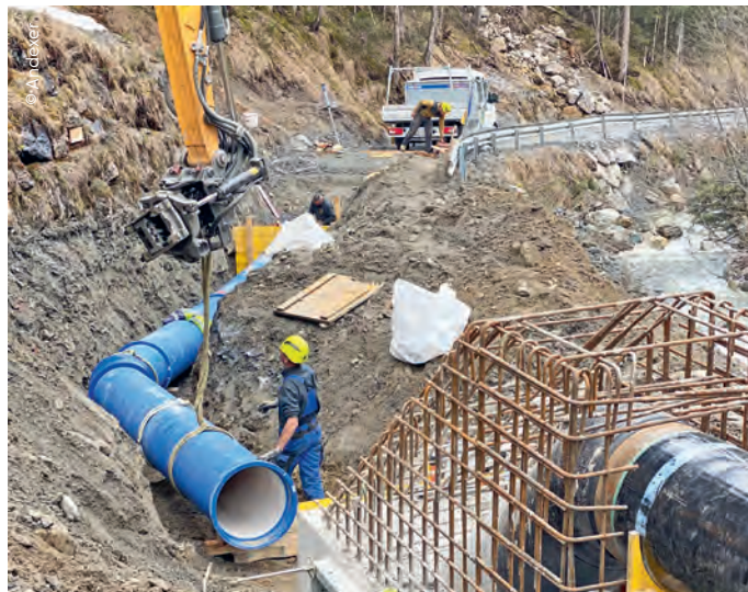
Abgesehen von zwei oberirdischen Rohrbrücken über den Ellmaubach wurden die beiden Kraftabstiege komplett unterirdisch verlegt.
