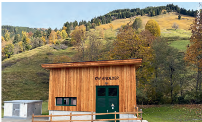
Das Maschinengebäude des Kleinwasserkraftwerks Andexer.
