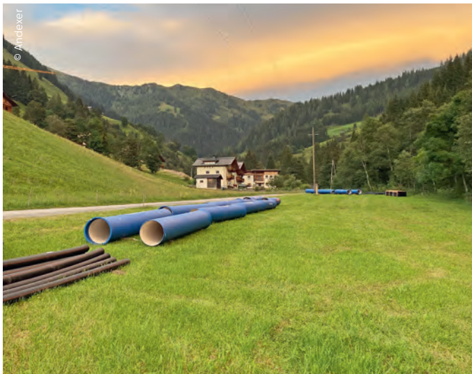
Bei der Materialauswahl der Druckrohrleitungen setzen die Betreiber auf duktile Gussrohre vom französischen Hersteller Saint-Gobain PAM.
