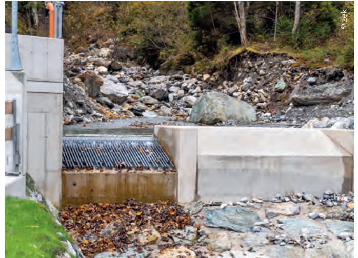
An der Wehranlage des Kraftwerks Andexer wird das Wasser durch ein spezielles Tiroler Wehr von Maschinenbau Mayrhofer eingezogen.
